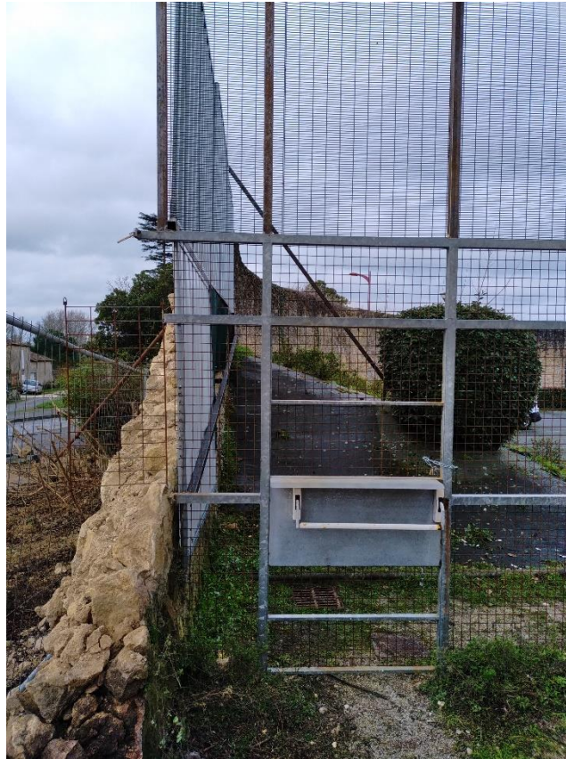
Source – Ginger CEBTP – photographie du remblai contre le mur sinistré
