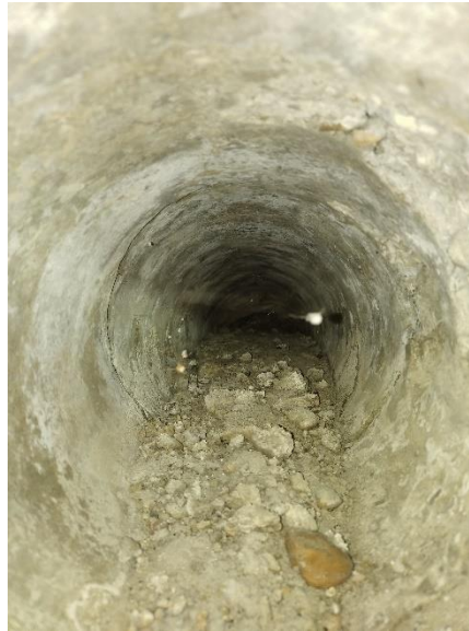
Source – Ginger CEBTP – Photographie d'une descente d'eau sous le mur
